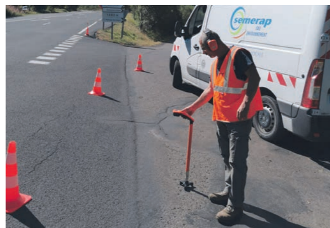
Recherche de fuites
