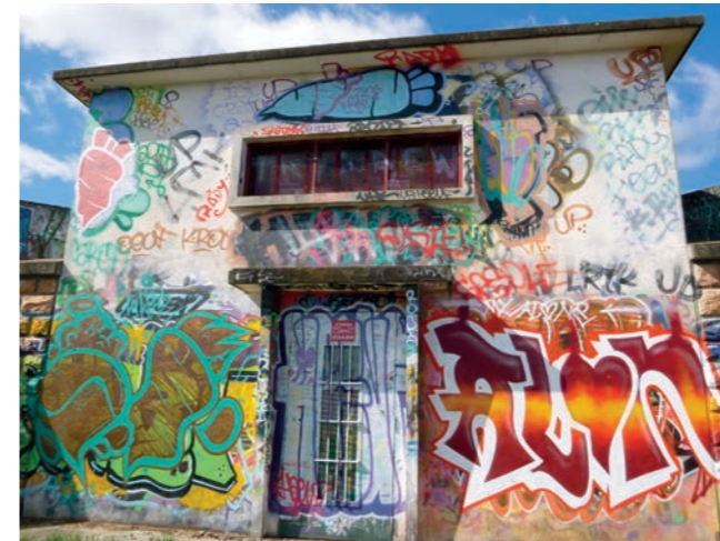
Réservoir de Cébazat - Avant
