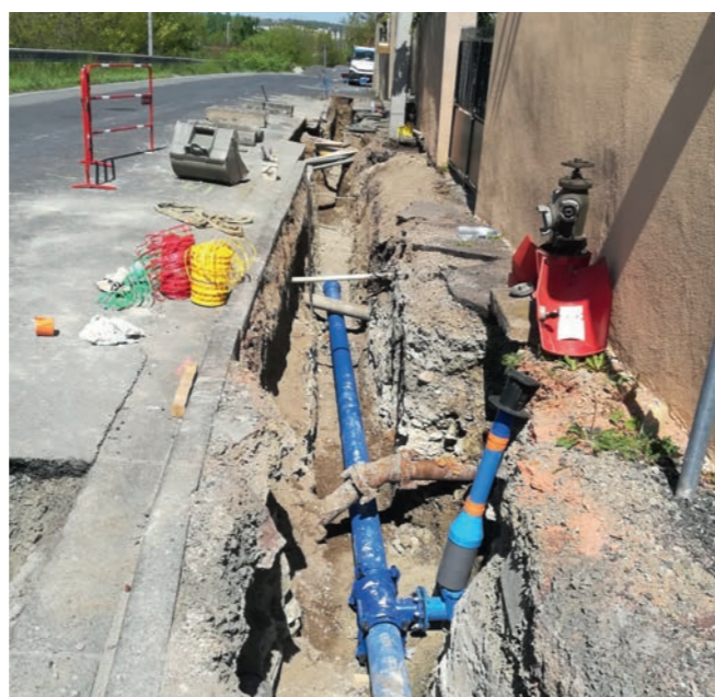
Renouvellement de conduites et de branchements d'eau potable.
