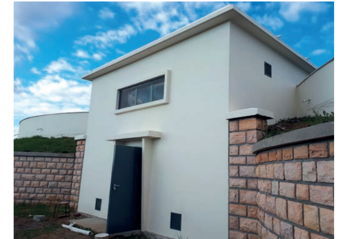
Réservoir de Cébazat - Après
